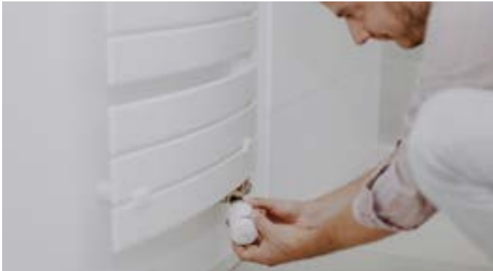
Mit wenigen Handgriffen konnte Herr Beier die Wisers Heizkörperthermostate selbst anbringen.
